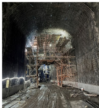
上流入り口補強工事
